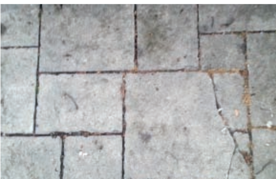
Sončni park: betonski tlak poti
