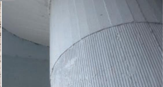
Kristlov blok: šrafura na stebru (beton pobarvan)
